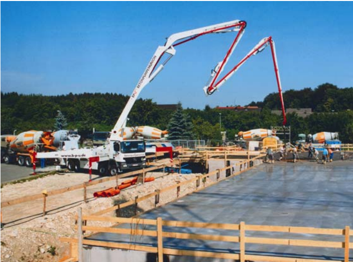
Abb.1: Betonpumpe M47 mit Abstützzylinder (Foto: Putzmeister)
